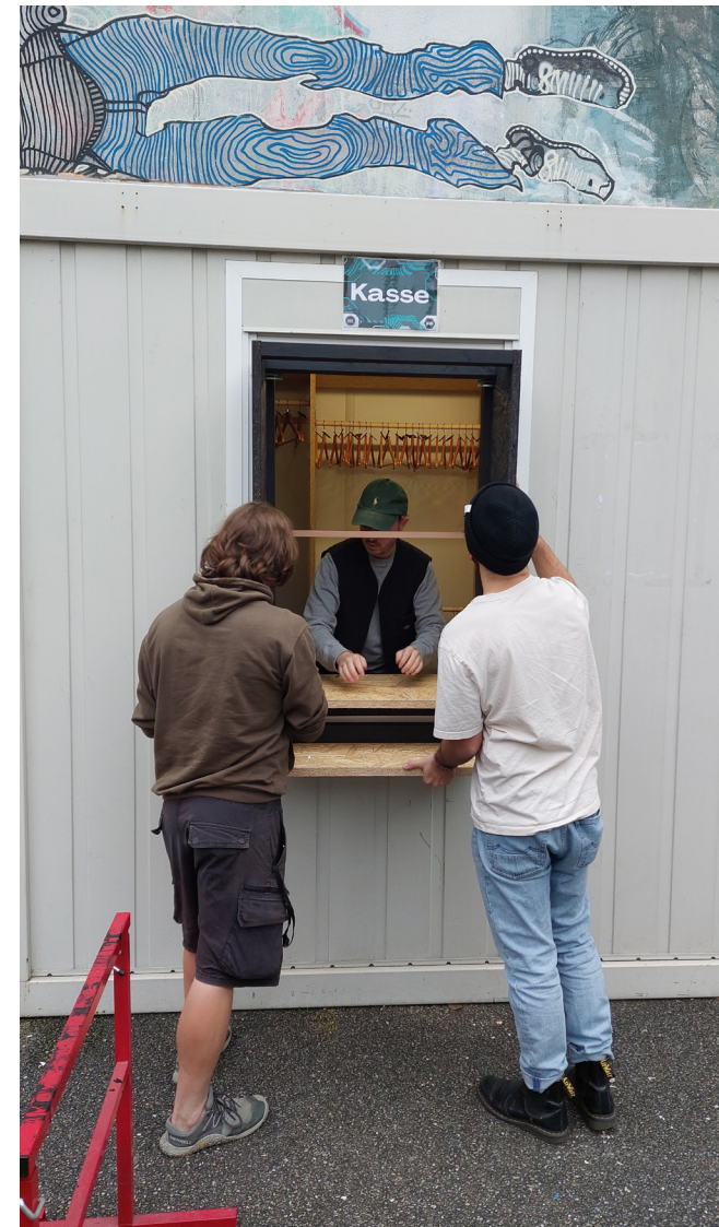
Über den Sommer wurde ein alter Bürocontainer zu einem Kassen- und Garderobenhäuschen umgebaut
